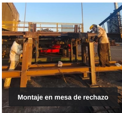
Soldadura y esmerilado en soportes tipo H
